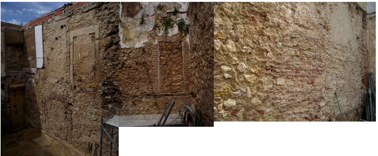
Fig. 8: Aspectos gerais dos elementos arquitetónicos identificados (elementos parietais na parede nordeste; portal com ombreiras e lintel em alvenaria de tijolo no piso superior da parede nordeste; armário de parede no piso superior da parede sudeste).
