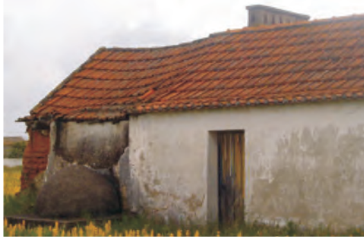
Aspecto do forno acoplado, de uma casa à entrada de Pinhal Novo.
