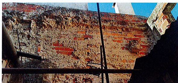
Foto 6 – Vista sobre o limite lateral do prédio urbano (sul), verificando-se que a parede de empena foi demolida deixando a descoberto a parede do edifício vizinho
