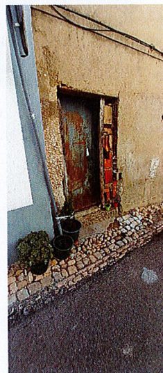
Foto 2 – Vista sobre o vão de acesso ao interior do edifício
