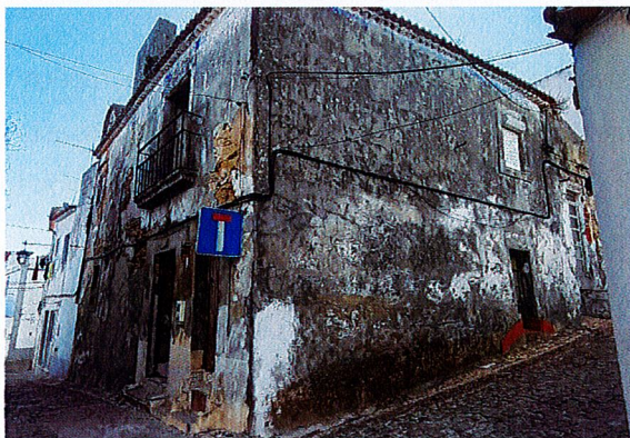
Foto 1 – Vista Geral sobre o edifício
