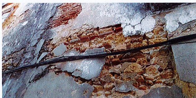
Foto 4 – Desagregação acentuada da alvenaria
