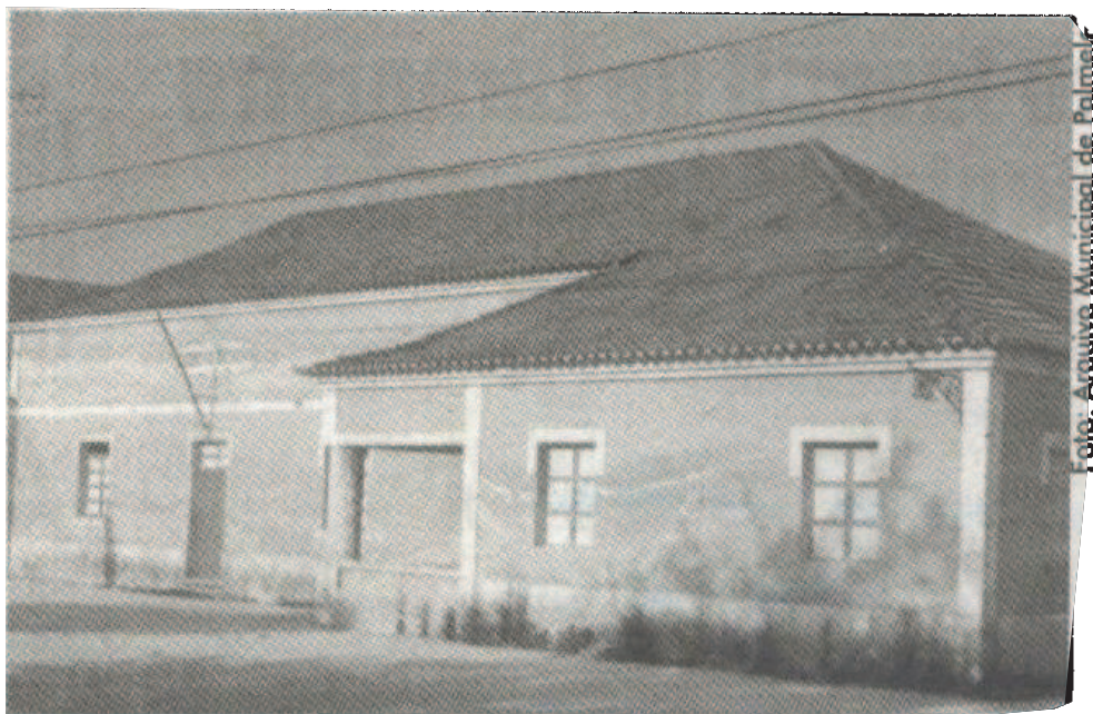
Construção inicial da Sede da Sociedade Recreativa e Instrutiva 1º de Janeiro de Lagoa do Calvo
