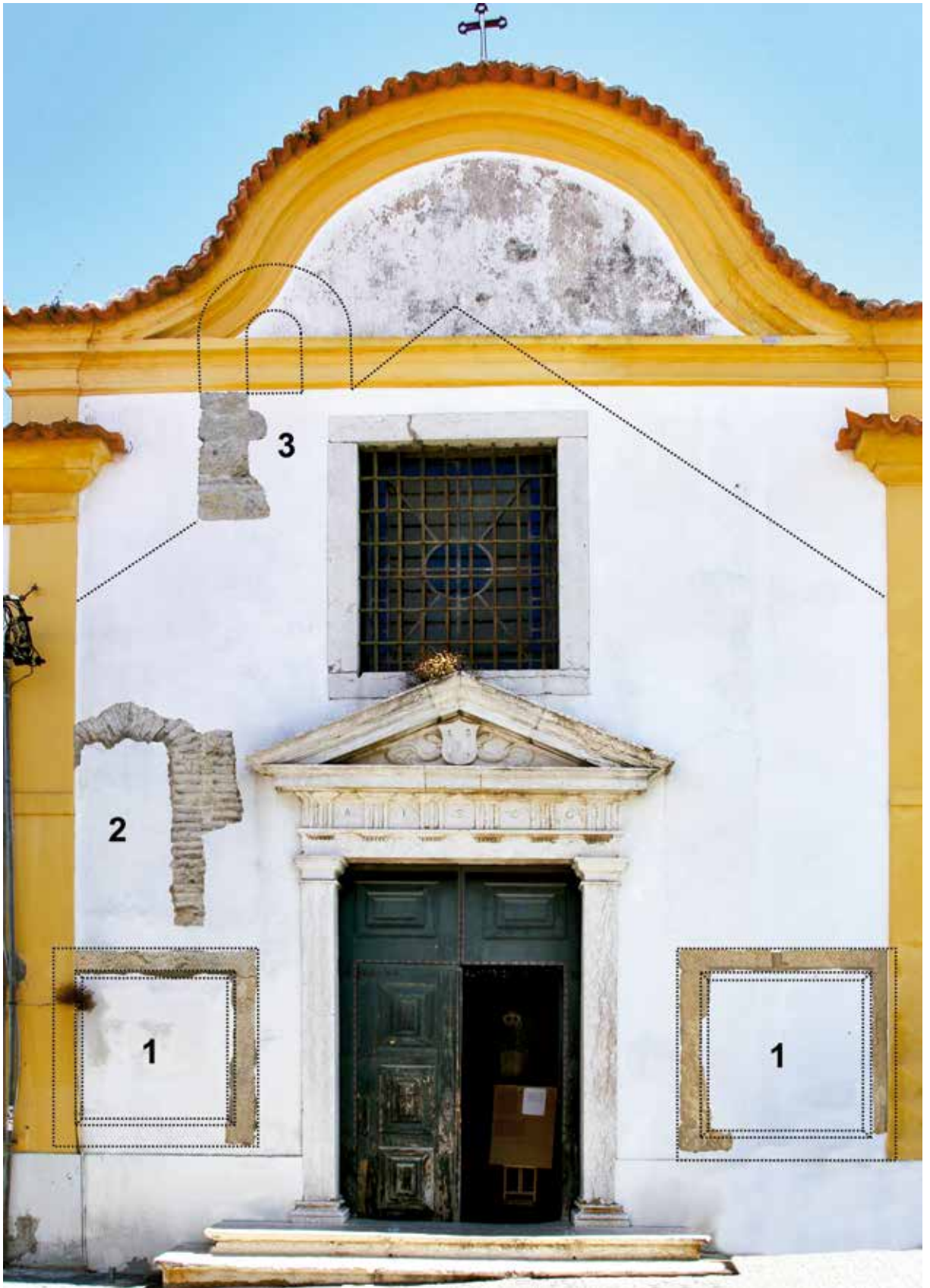
Fig. 3 – Sobreposição, à escala, sobre a fachada da igreja, dos elementos arquitectónicos recentemente identificados. 1 - «Janelas de Pilatos» (?); 2 - Vão em tijoleira; 3 - Campanário
