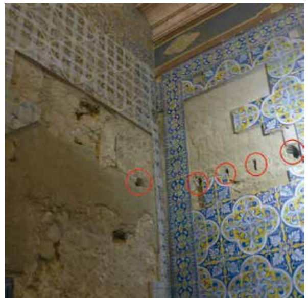
Fig. 2 – Aspecto dos possíveis agulheiros do antigo coro, escondidos pelos painéis de azulejos
