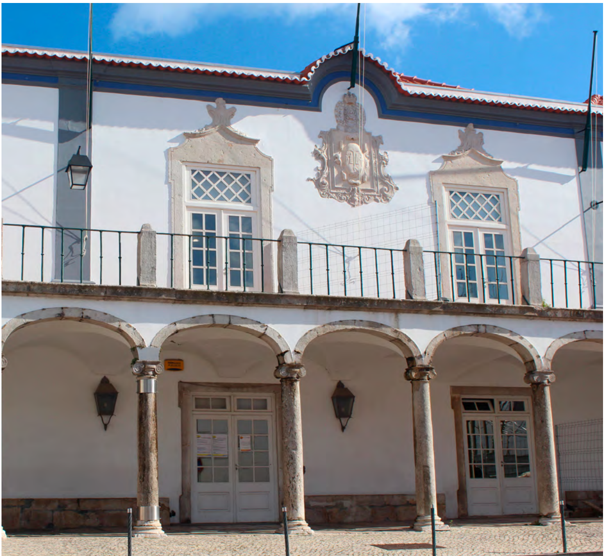
Fachada dos Paços do Concelho de Palmela.
