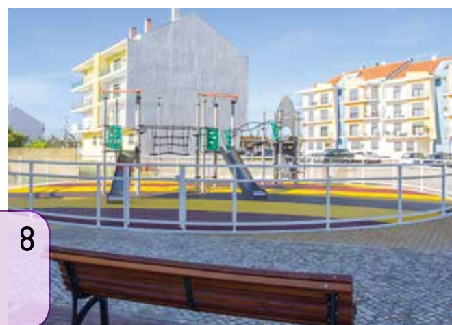
8 Em Pinhal Novo sul, nasceu um novo EJR, entre a Rua António Lopes Mendes e a Rua Maria Eduarda Ferreira
