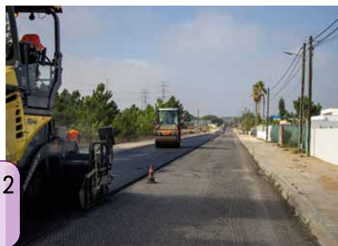
1 Pavimentação da Rua Manuel Xavier de Carvalho – 2.ª fase (Cabanas) | Concluída
