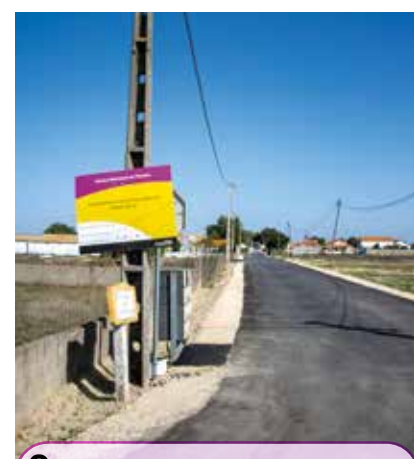
6 Pavimentação da Rua do Anselmo (Pinhal Novo) | A decorrer
