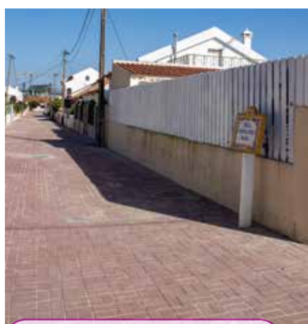
4 Repavimentação da Rua Jaime Lopes Baião (Venda do Alcaide) | Concluída
