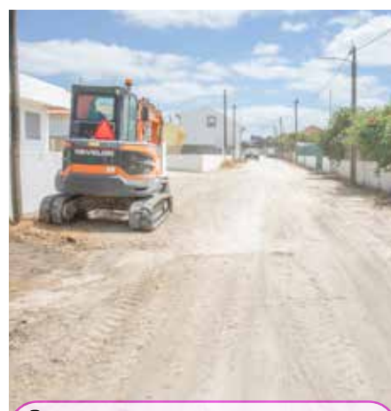
6 Estão a começar os trabalhos de infraestruturação da Rua Zeca Afonso (Quinta do Canastra – Sobral)
