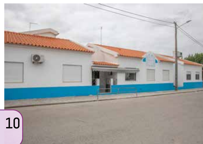
9 Tiveram início as obras de re-qualificação do edifício sede do Forninho Futebol Clube...
