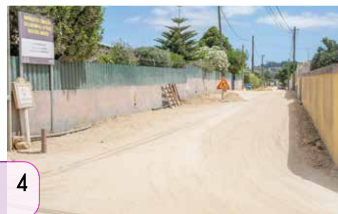
Infraestruturação da Rua dos Amigos (Lagoinha) a decorrer
