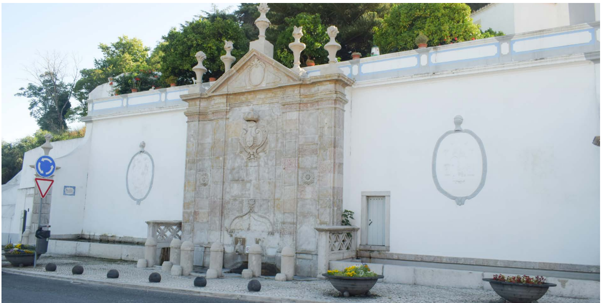
Figura 1 – Vista geral antes da intervenção em agosto de 2023. Foto: FH.
