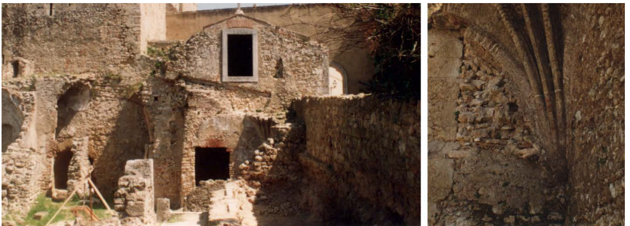
Fig. 8 e 9 – Antiga sacristia, reabilitada para Centro de Estudos da Ordem de Santiago. Os arranques ainda existentes de nervuras de abóbadas foram mantidos e apoiam com credibilidade uma simulação, num novo material, duma cobertura que protege a entrada do antigo espaço, reabilitado para nova função (Fotos S. I.).
