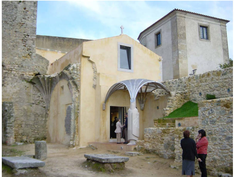
Fig. 12 e 13 – O apoio em falta foi livremente assumido como elemento escultórico antropomórfico, sugerindo um monge guerreiro da Ordem de Santiago, associando à peça, necessária como elemento estrutural, uma carga simbólica relacionada com a nova função do espaço reabilitado (Desenho e foto S. I.).
