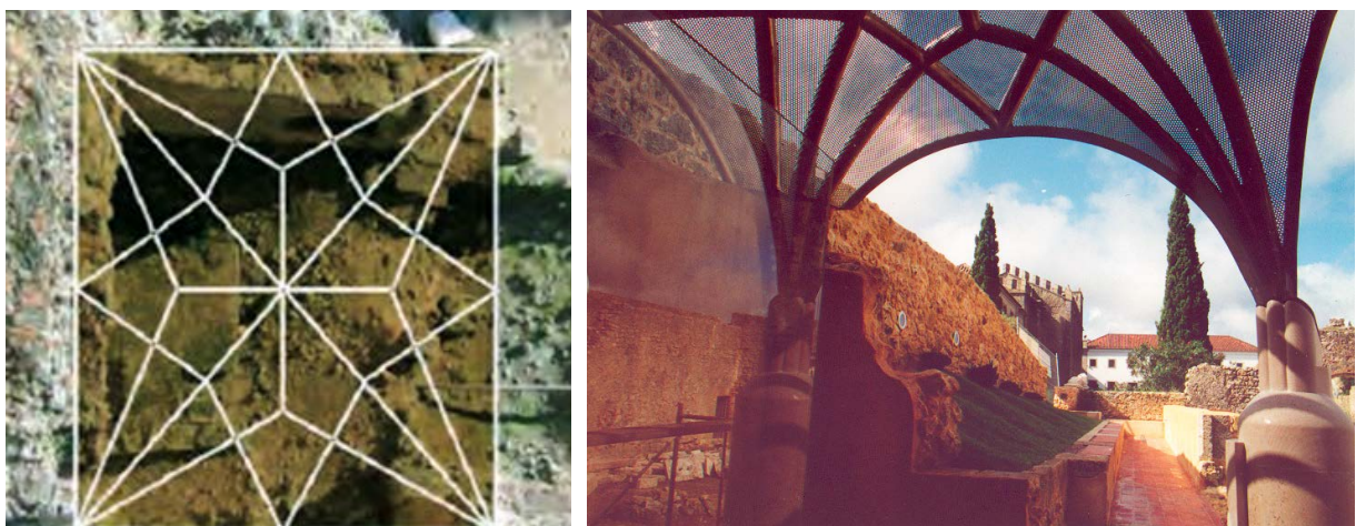
Fig. 10 e 11 – Estudo da geometria da abóbada a partir dos apoios ainda detectáveis. A substância física original mantém-se e a nova cobertura materializa a sugestão dum espaço anteriormente coberto (Esquema e foto S. I.).
