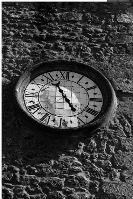
Mostrador do Relógio da Igreja de Santiago
