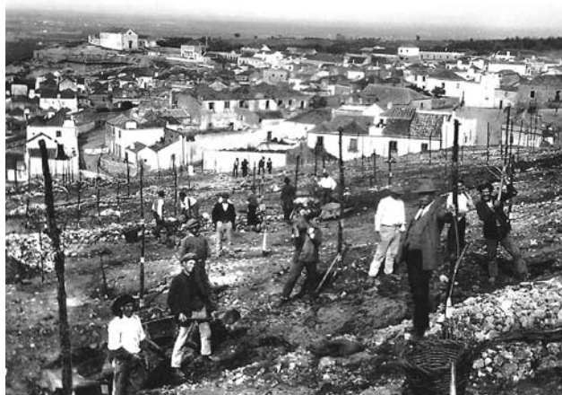
Construção do Parque do Castelo, década de 20, séc. XX. Autor: Manuel Giraldes da Silva
