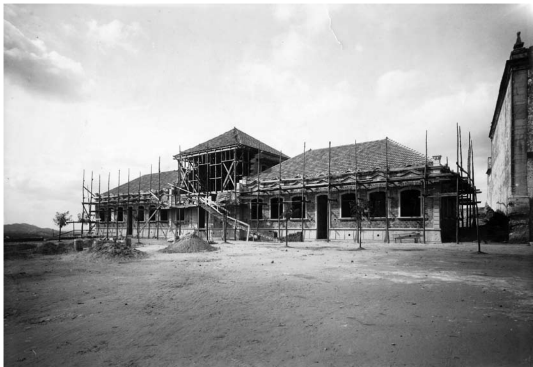
Construção da Escola Hermenegildo Capelo, no Largo S. João, década de 20, século XX,. Autor: Foto Cabecinha
