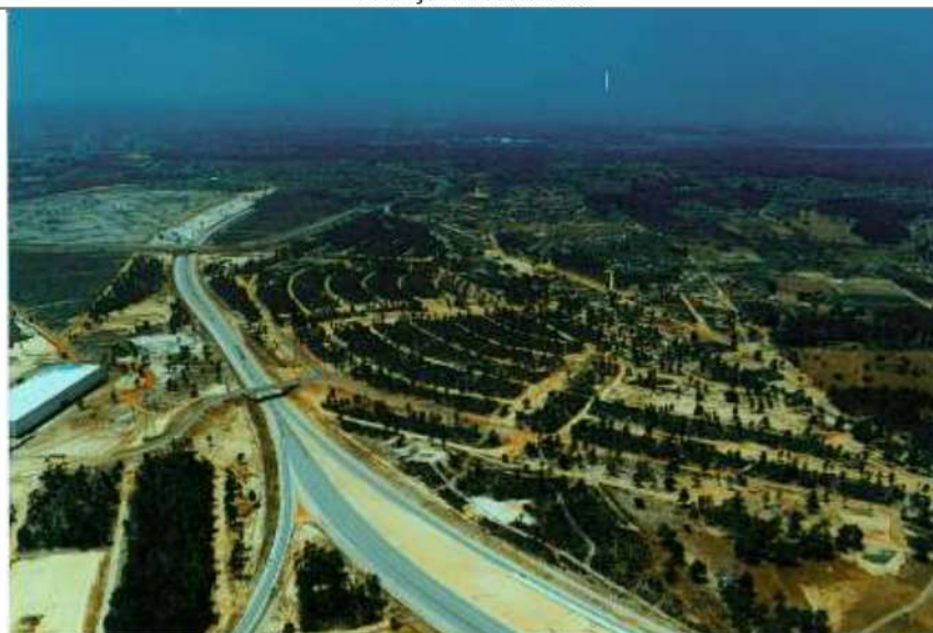
FIGURA 75 – FOTOGRAFIA AÉREA DA ÁREA DA MARQUÊSA II – 2.ª FASE E DO EIXO FERROVIÁRIO NORTE-SUL NA ZONA DA ESTAÇÃO DE PENALVA
