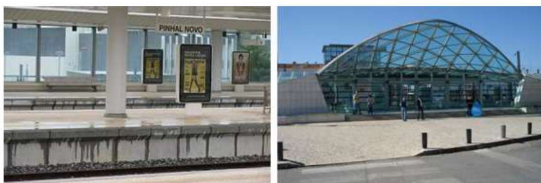
FIGURA 34 - ESTAÇÃO DE PINHAL NOVO
