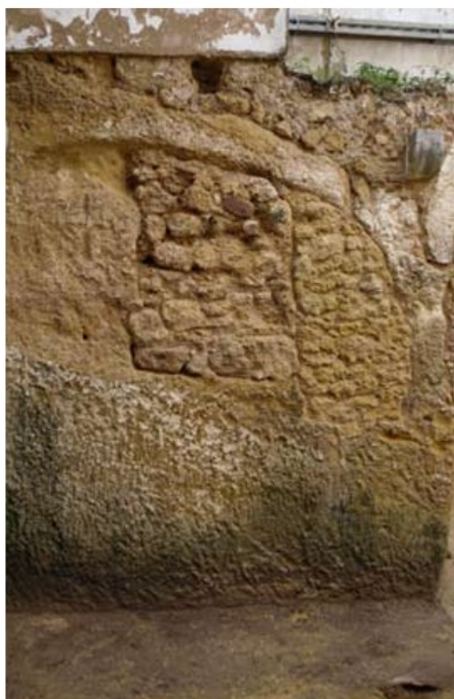
Perspetiva do arco escavado na rocha, respetivos entaipamentos e motivo cruciforme (S.P. 1).
