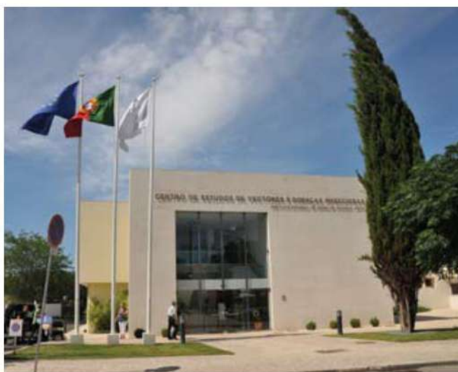
Novas instalações do CEVDI-INSA projectadas pelo Arq. Pardal Monteiro. Águas de Moura, concelho de Palmela.
