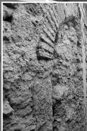
Porta de arco quebrado. Acesso primitivo do edifício dos séculos XV/XVI, que preserva as suas componentes originais: a soleira, ombreira e arco em tijolo artesanal, ambos biselados.
