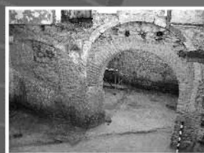
Detalhe dos Arcos da sala I. Técnicas e soluções construtivas aplicadas durante 500 anos. De esquerda para a direita: Arco escavado na rocha com motivo cruziforme gravado (séculos XIV-XV), sobreposto por arco Quinhentista, composto por blocos de pedra, abaixo do qual é construído um novo arco em tijolo artesanal, para rebaixar o piso do 1.º andar da casa (momento pós-terramoto de 1755).
