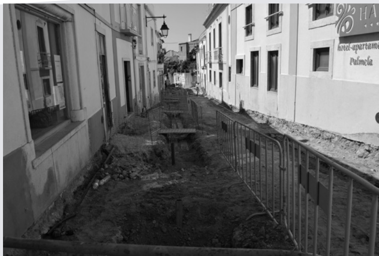
Aspecto geral dos trabalhos de obra na Rua Contra-Almirante Jaime Afreixo.
