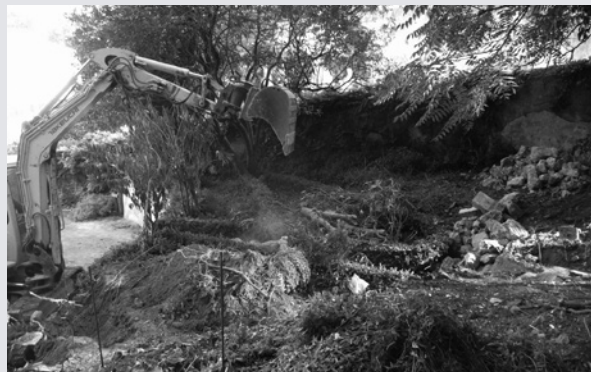
Trabalhos de construção do novo anfiteatro.
