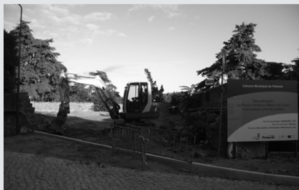
Aspecto dos trabalhos no interior do revelim.
