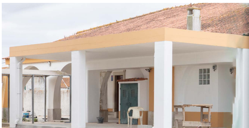
1. Em curso a empreitada de reforço estrutural da EB Palhota
