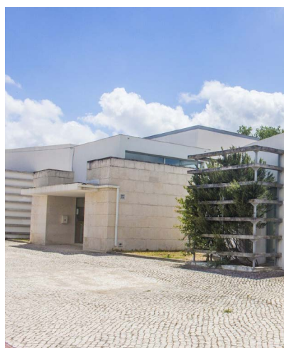
4. Já arrancou a empreitada de requalificação e eficiência energética do Centro Cultural de Poceirão
