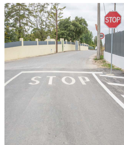
6. Está concluída a infraestruturização de um troço da Rua José da Cruz Coelho, no Terrim
