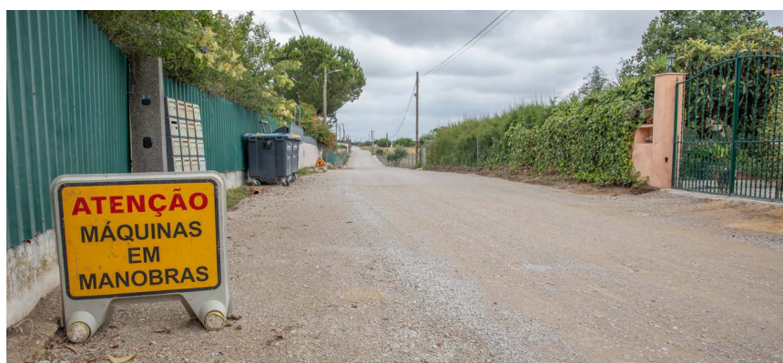
7. Na Agualva, está a decorrer a pavimentação da Rua Francisco Romão
