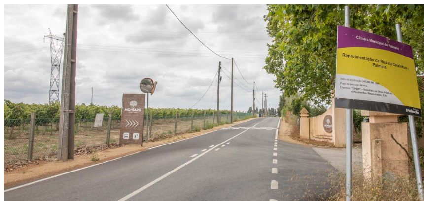
9. A repavimentação da Rua do Caixinas (Algeruz) está concluída...
