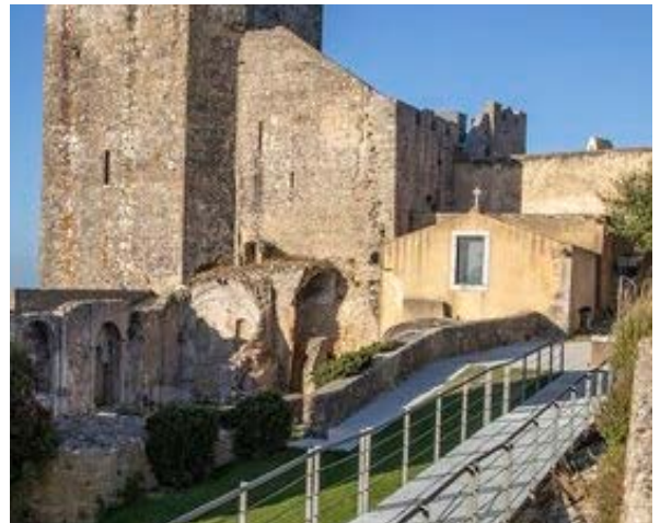
Figura 1 – Estrutura pedonal para pessoas com mobilidade condicionada, no Castelo de Palmela
