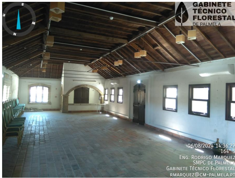
FOTO VII – Sala de Reuniões do edifício municipal no Espaço Fortuna
