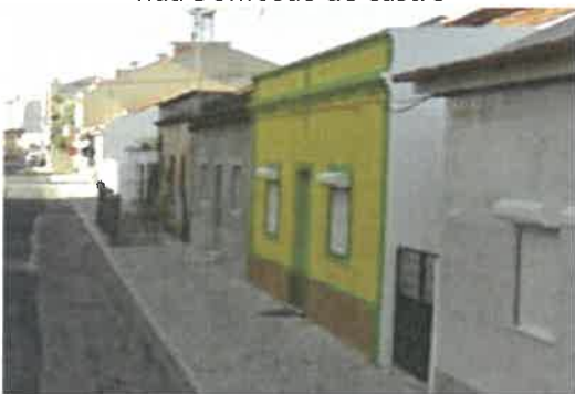
Rua Dom João de Castro
