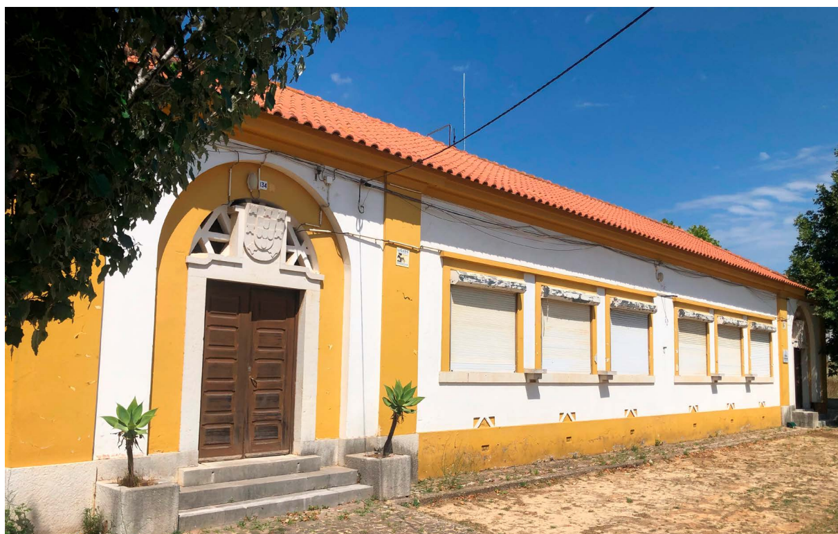
Figura 1 - Antiga Escola Primária de Aires: fachada principal
