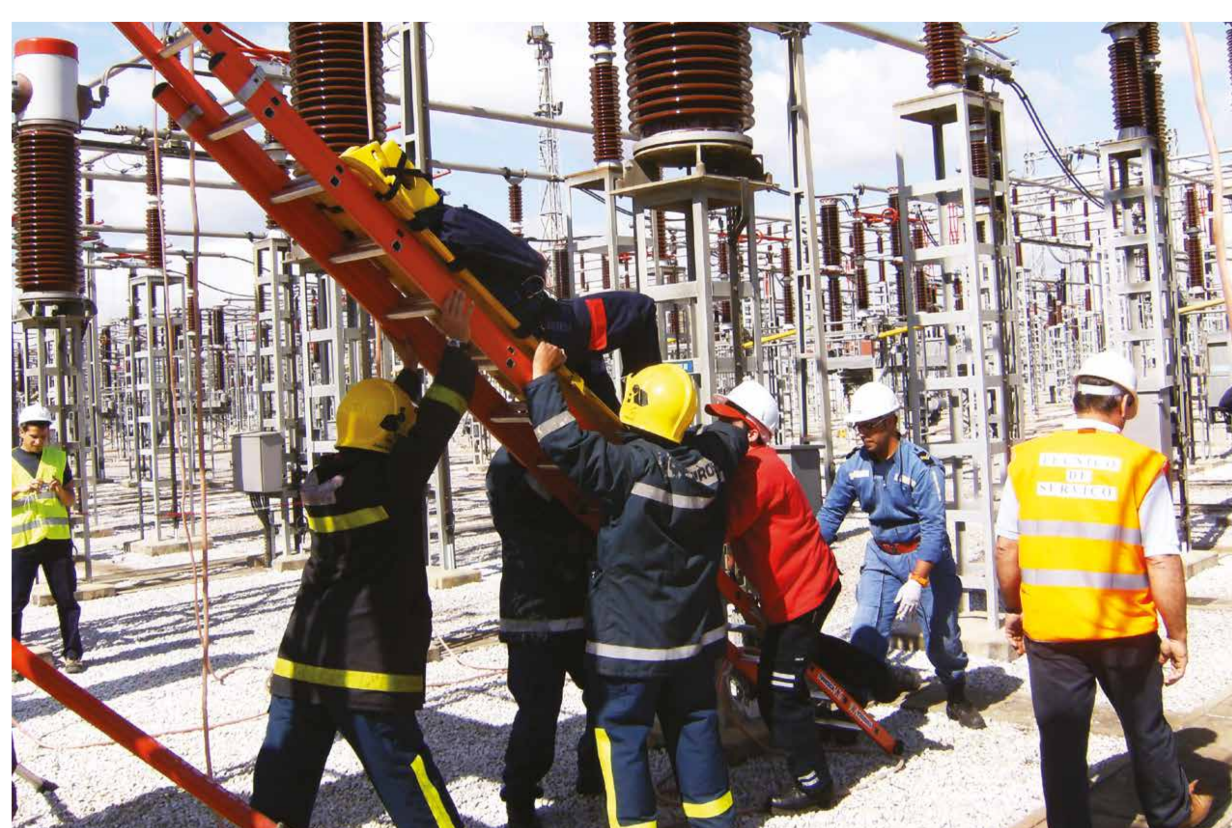
Simulacro Subestação EDP, Palmela - 2008 |
