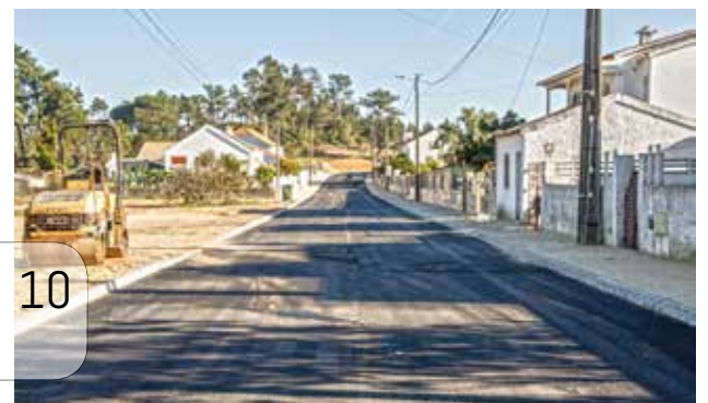
10 Concluída a pavimentação da Rua das Laranjeiras, no Bairro Assunção Piedade, freguesia de Quinta do Anjo.
